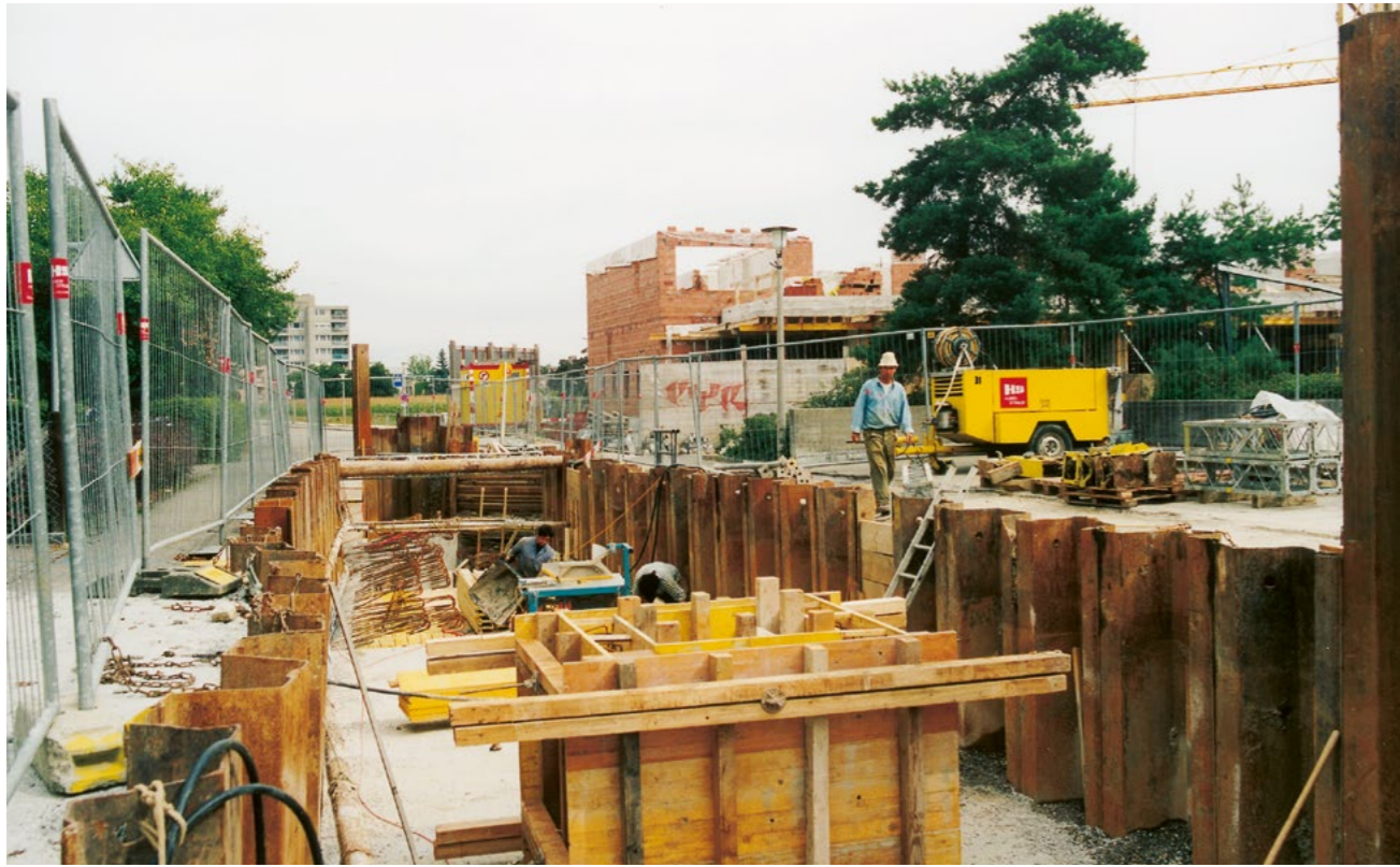
Die beiden WBZ-Gebäude sind durch einen unterirdischen Verbindungsgang unter der Aumattstrasse hindurch verbunden. Der Altbau an der Aumattstrasse 70/72 steht nicht mehr, doch ein Teil des Verbindungsganges ist erhalten geblieben und dient heute als Lager.
