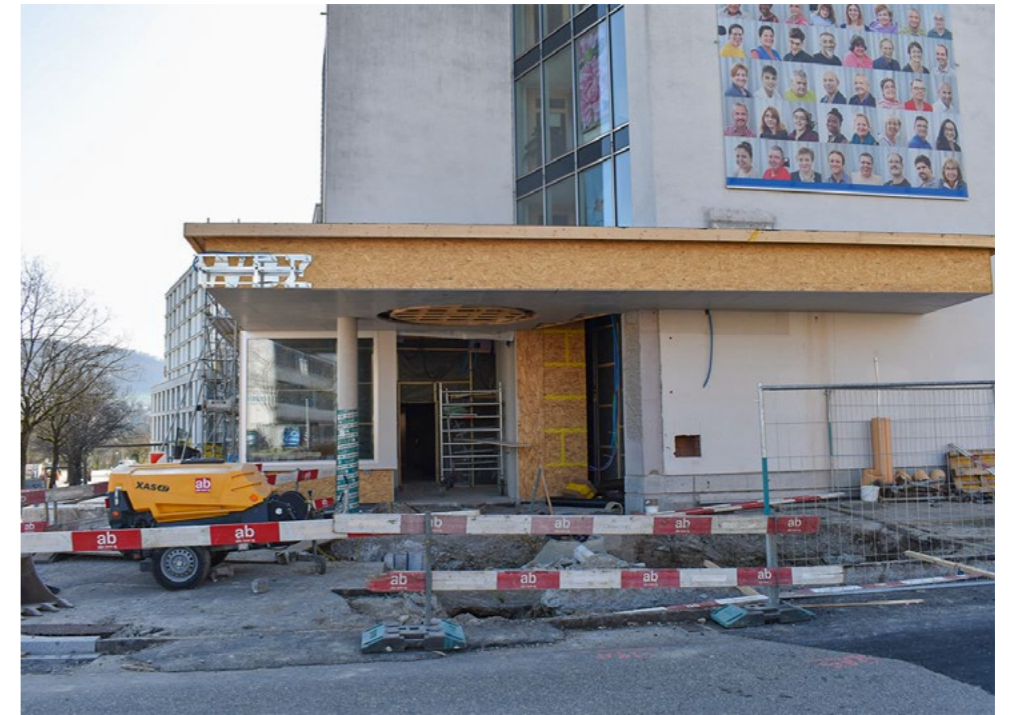
Auch der Eingangsbereich bekommt ein Facelifting.
