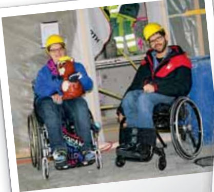
Zu Besuch auf der Baustelle.
