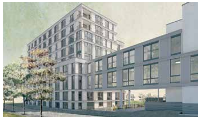
Die Verbindungsbrücke macht aus dem Bestandsgebäude 71 und dem «Neubau 2020» ein zusammenhängendes Gebäude.
