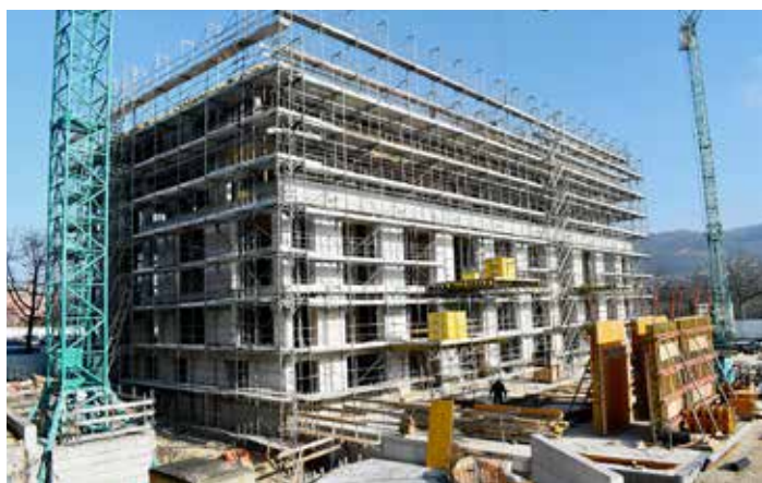
Bald wird der Rohbau fertiggestellt sein.
